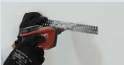
Esempi di vincolo montante con staffa
