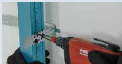
Esempi di vincolo montante con staffa
