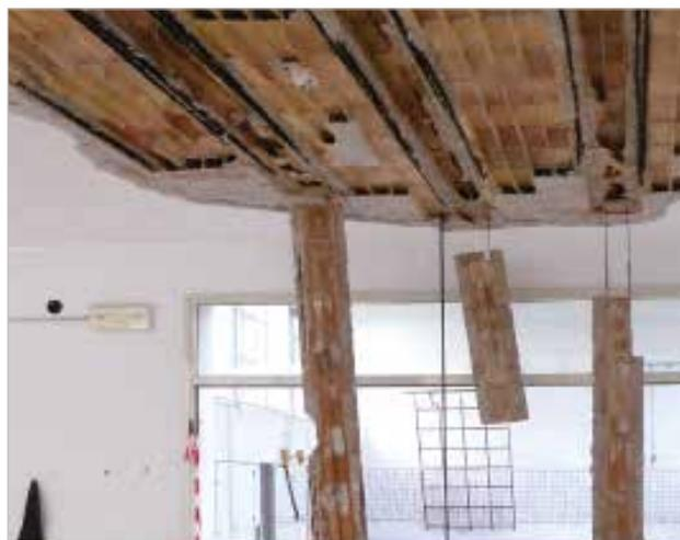
Le ultime Norme Tecniche per le Costruzioni hanno sottolineato la necessità di verificare anche i rischi legati ai cosiddetti **elementi secondari**, che durante la scossa di terremoto possono creare situazioni di pericolo anche se non strutturali, ma dotati di masse significative per l'incolumità delle persone.
