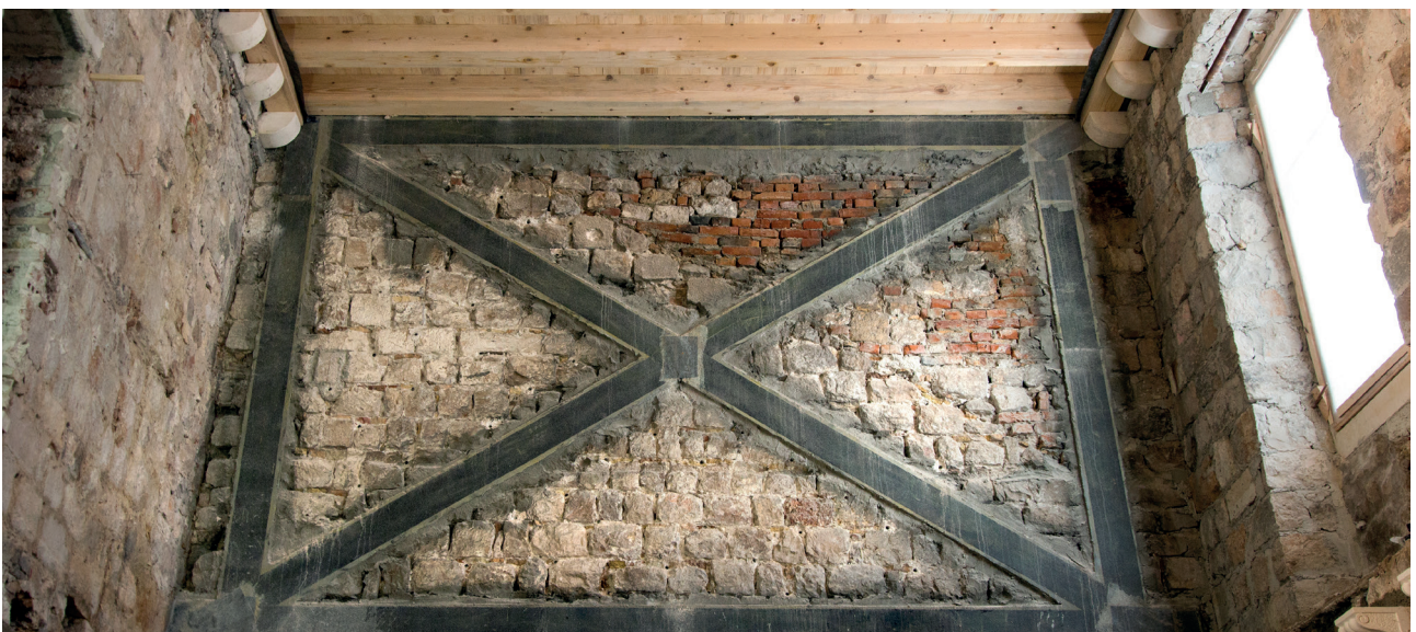
Rinforzo di maschio murario per azioni nel piano con sistema CFRP
