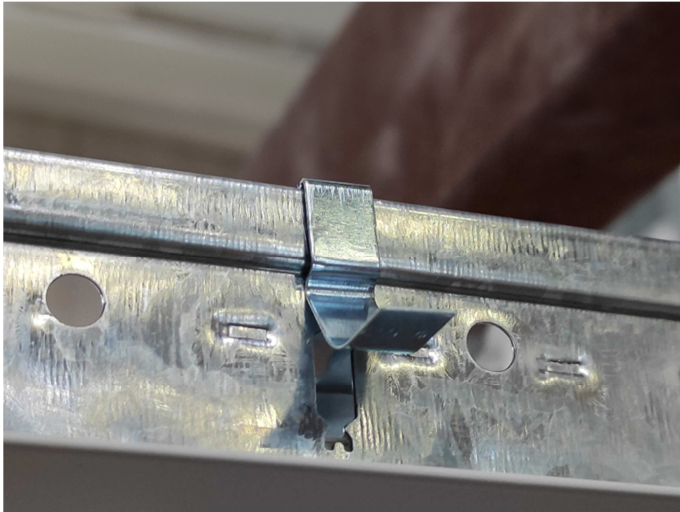
Fotografia di una clip antisollevamento in acciaio
