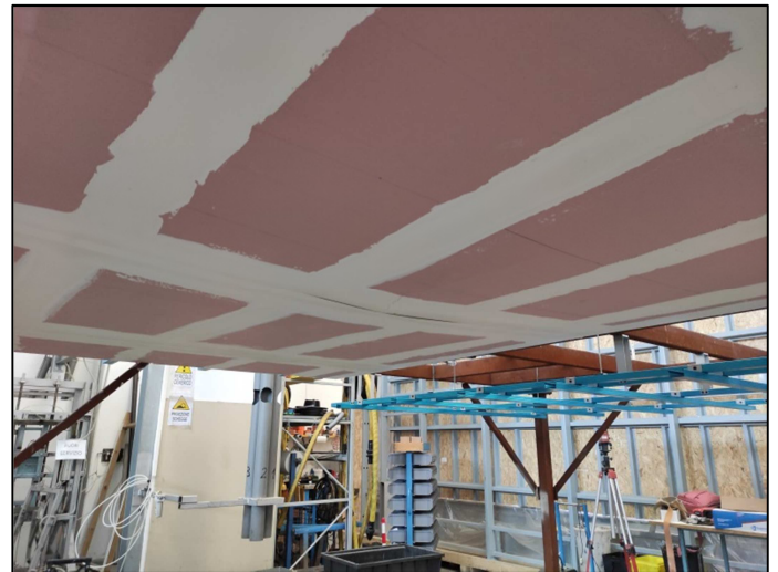
Impatto n. 9 - Particolare dell'intradosso
