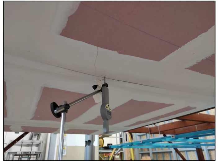
Impatto n. 6 - Particolare dell'intradosso
