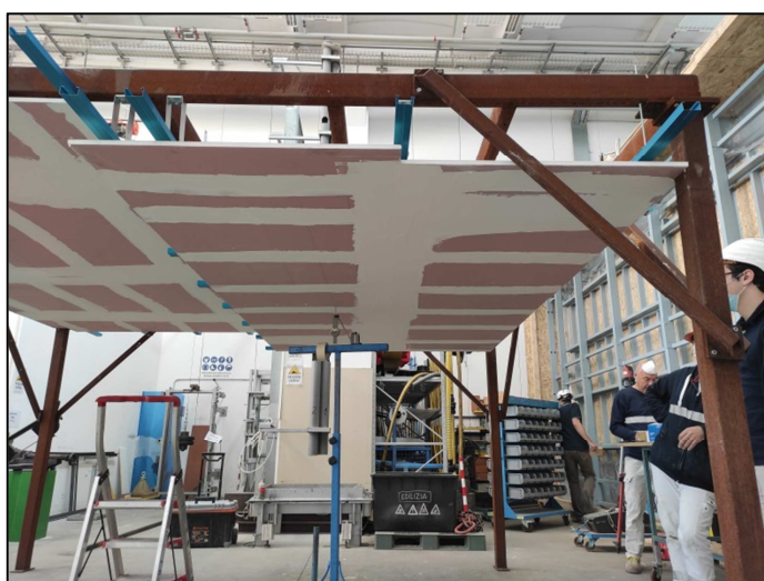
Fotografia della superficie d'intradosso dell'oggetto
