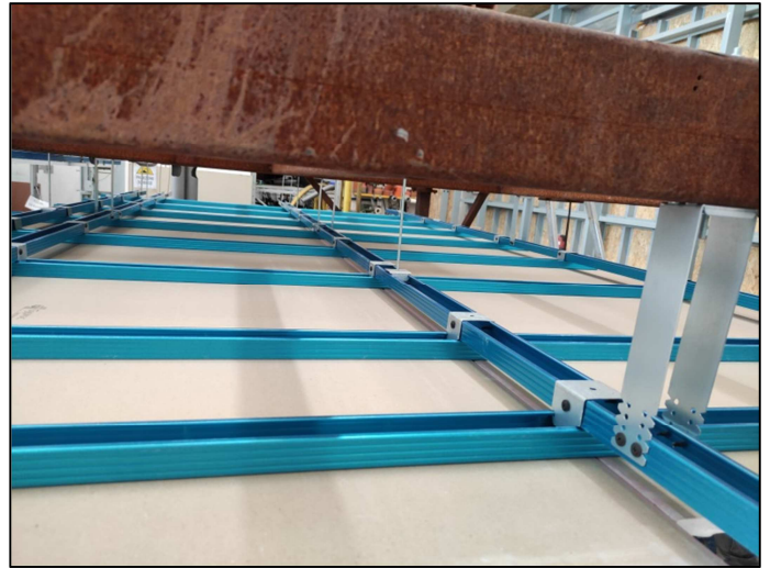
Particolare della staffa regolabile avvitata
