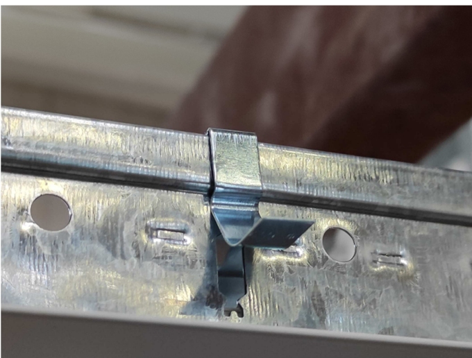
Fotografia di una clip antisollevamento in acciaio
