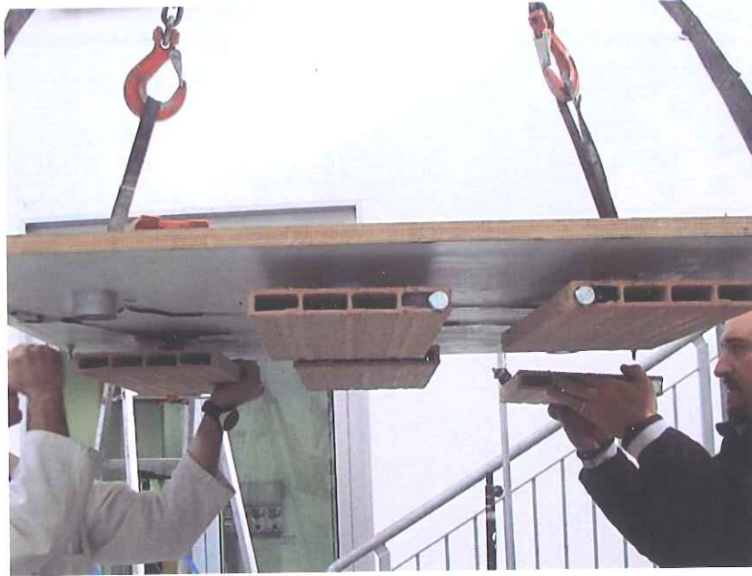
Posizionamento di elementi tavella-piastra sotto il pannello in legno multistrato.
