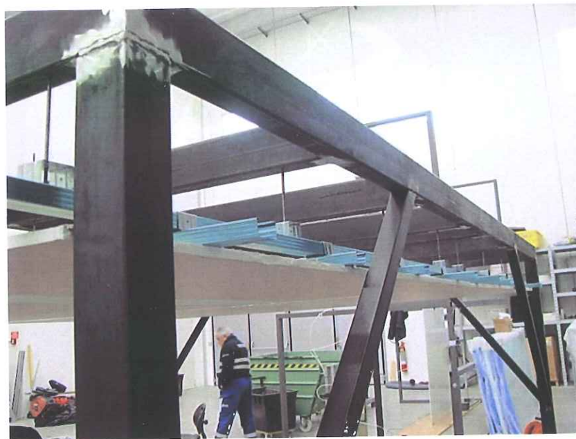
Particolare della struttura metallica di sostegno e campione allestito prima della prova.
