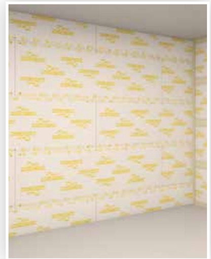
6. Installazione del 2° strato di lastre
