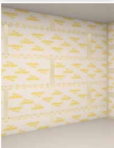
7. Stuccatura del 2° strato dei giunti verticali
