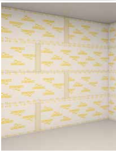
4. Stuccatura dei giunti verticali
