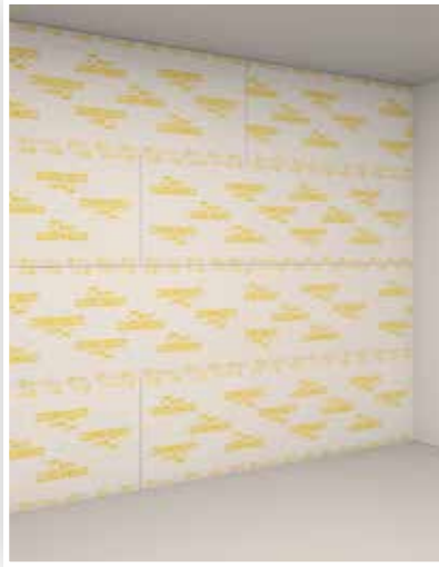
2. Lastre installate in posizione orizzontale
