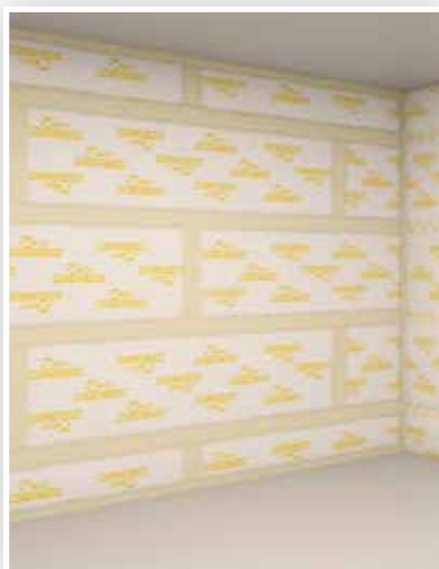
8. Stuccatura del 2° strato dei giunti orizzontali
