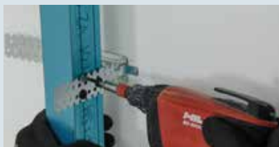
Esempi di vincolo montante con staffa
